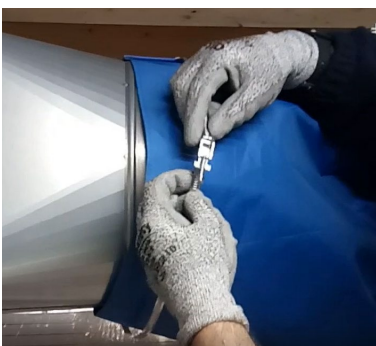
Fissare il canale all'imbocco della macchina con l'apposita fascetta in dotazione
